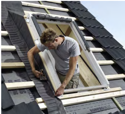
4. Für den regensicheren Anschluss die mitgelieferte Anschlusschürze BFX montieren.
