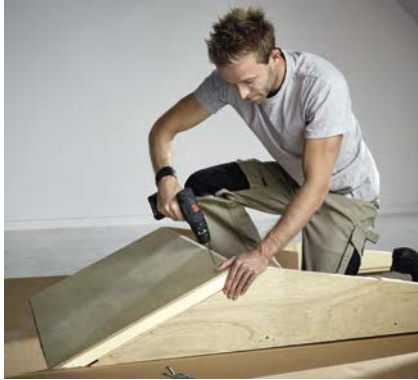
1. Die im Lieferumfang enthaltenen Dämmteile montieren.
