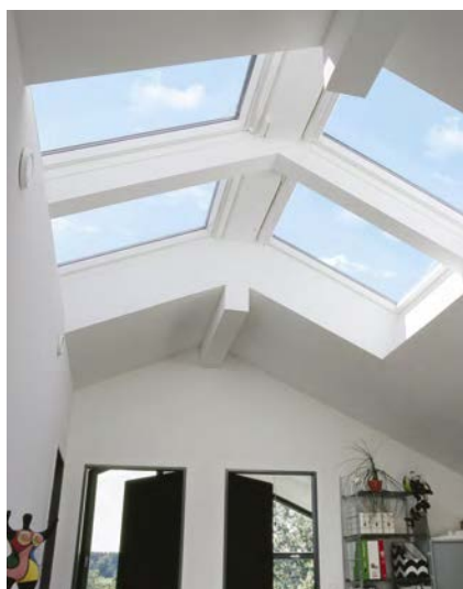
Innenansicht einer Firstlösung
