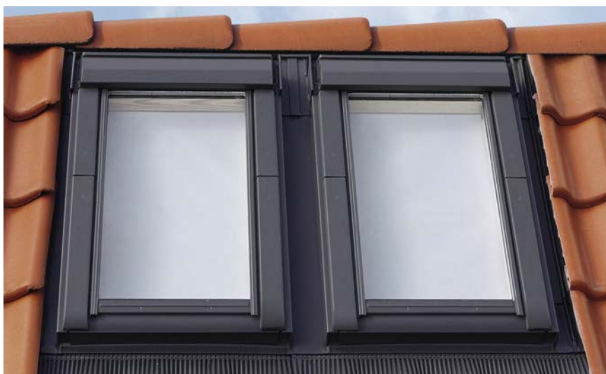
Einbau mit durchgehenden Firstziegel
